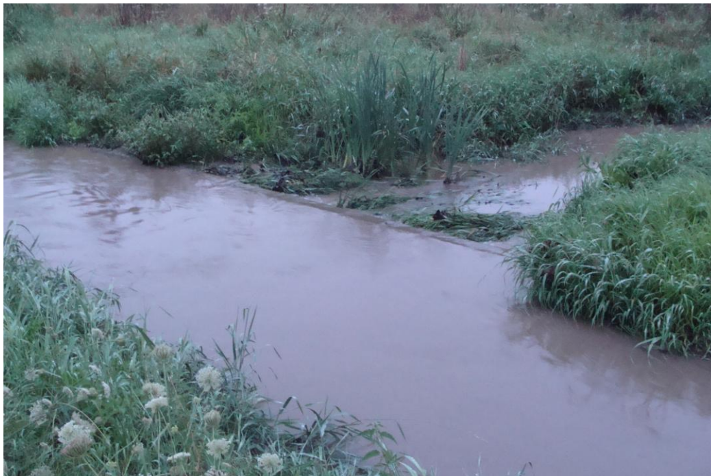
Foto : inloopconstructie wachtbekken Maasrode (augustus 2010)
