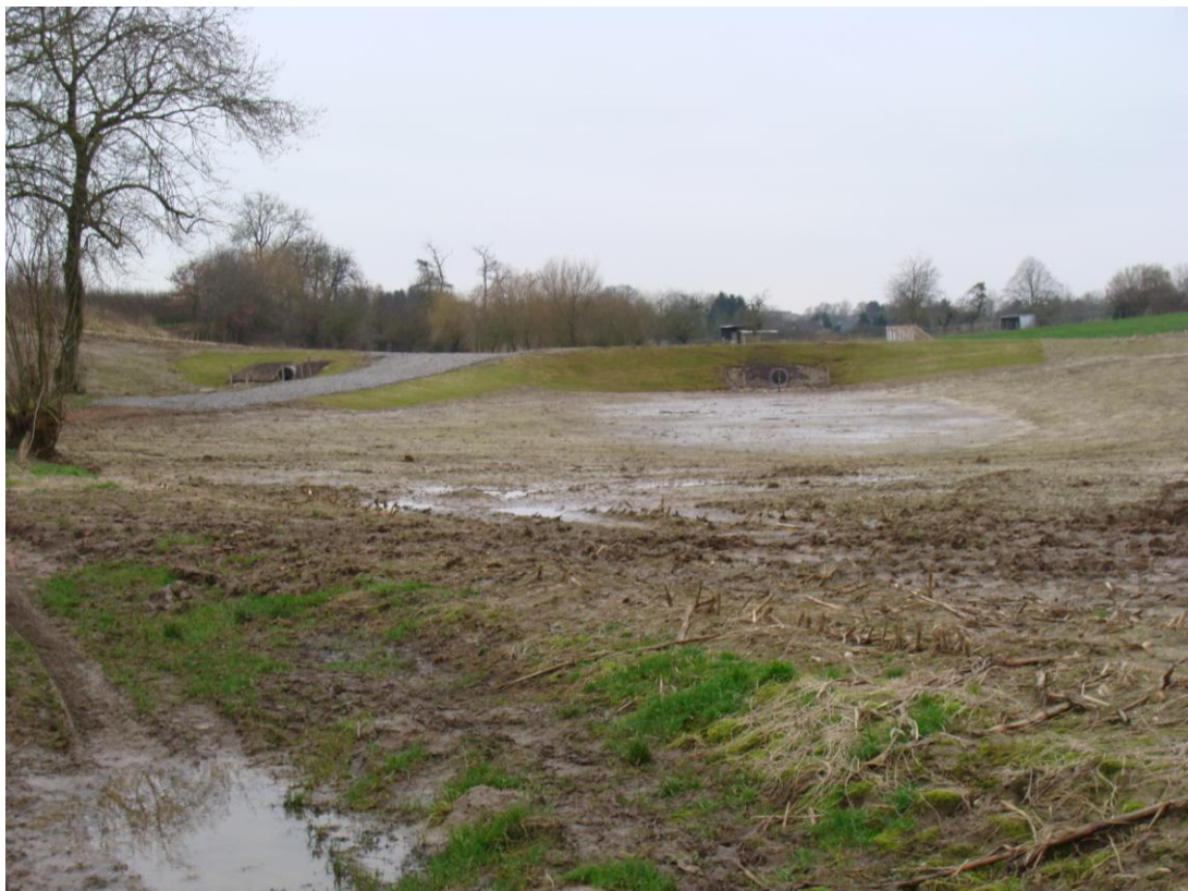
Foto (zelfde locatie als hierboven) : Toestand na de werken. De Greb wordt 'afgedamd' waardoor water- en modderstromen worden opgevangen. (foto : Karel Vandaele)
