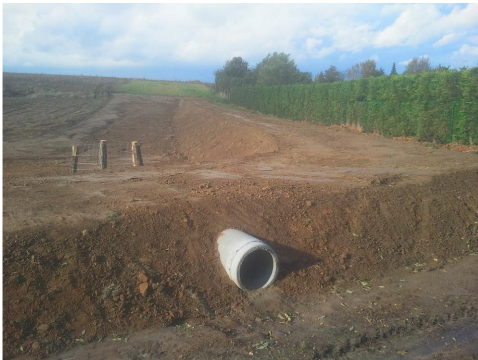
Foto (zelfde locatie als hierboven) : Toestand na de werken. De water- en modderstromen worden opgevangen door een aarden dam.
