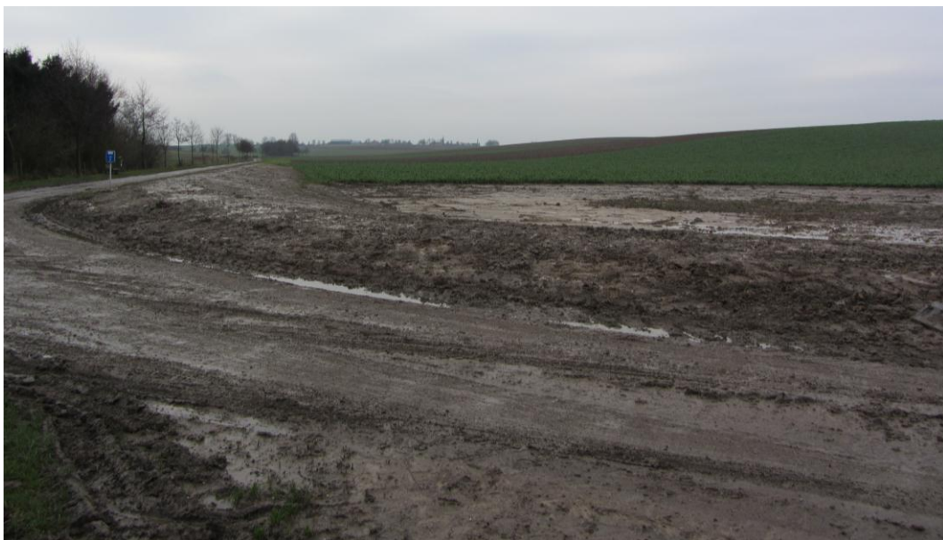
Foto 2: nieuw aangelegde dam vlak na het einde van de werken. In het voorjaar zal de dam nog ingezaaid worden met gras.
