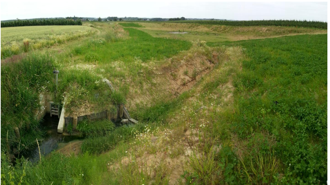
Foto 3 : Toestand na de werken; zicht op knijpconstructie op de Katrienmeerbeek en inloop naar bovenste bufferzone (foto genomen op zelfde locatie als foto 2).
