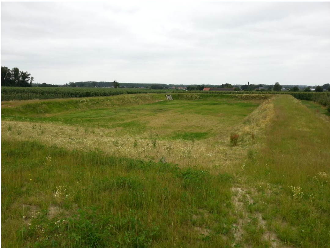
Foto 5 : Toestand na de werken; zicht op onderste bufferzone (foto genomen op zelfde locatie als foto 4)
