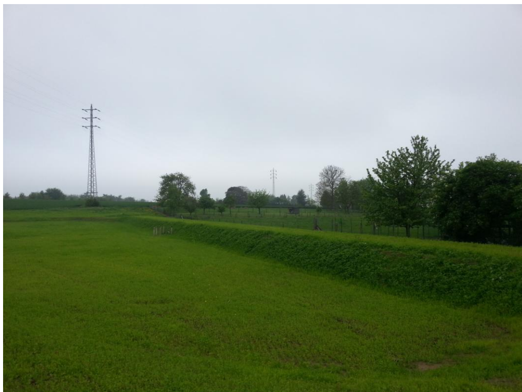
Foto : locatie na aanleg nieuwe erosiedam met bufferzone (mei 2013)
