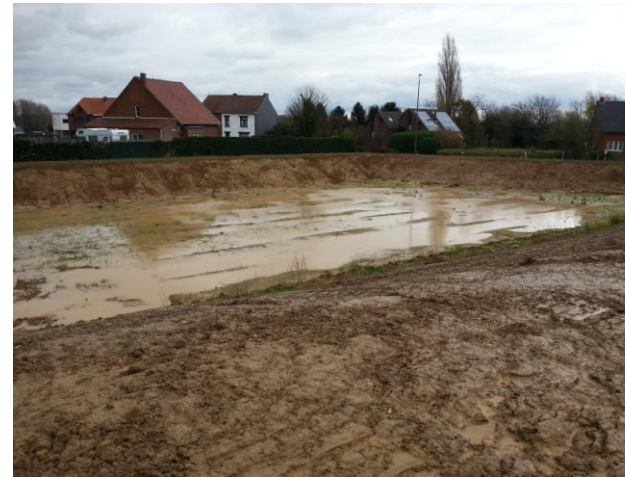
Toestand na de werken (bufferbekken)
