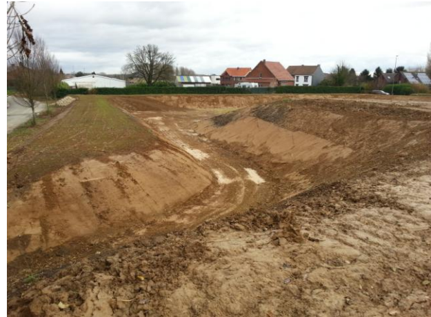
Toestand na de werken (instroomgeul naar bufferbekken)
