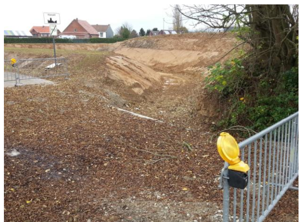
Toestand na de werken (wegverlaging en instroomgeul naar bufferbekken)
