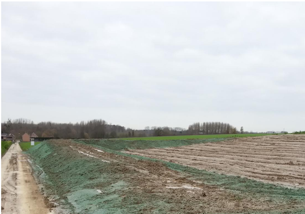
Foto : zicht op hoek van perceel (rechts) na de werken
