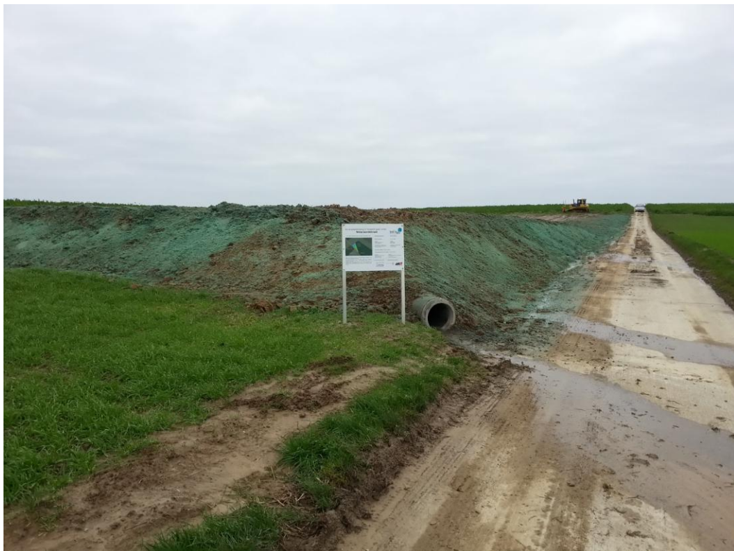
Foto : Zicht op het perceel na de werken
