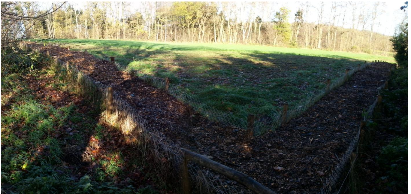
Foto 6 : zicht op hakselhoutdam onderaan perceel (nieuwe toestand)
