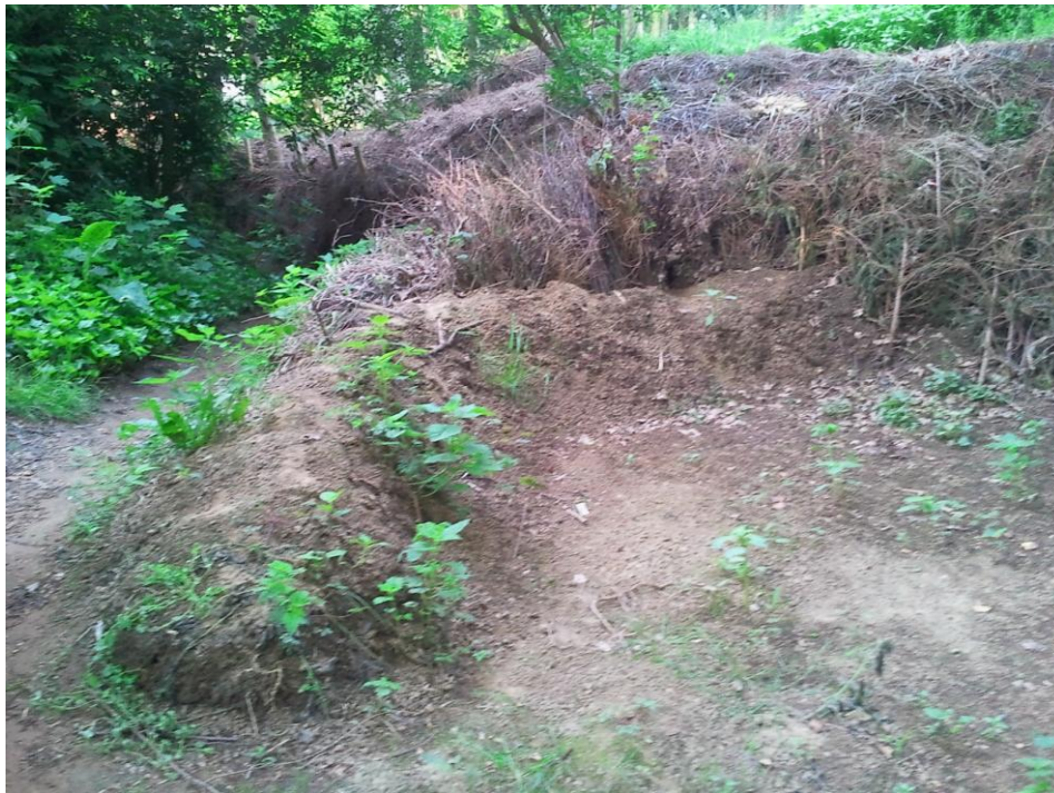
Foto 3 : bestaande 'beschermingsmaatregelen' (walleetje) in holle weg, aangelegd door bewoners
