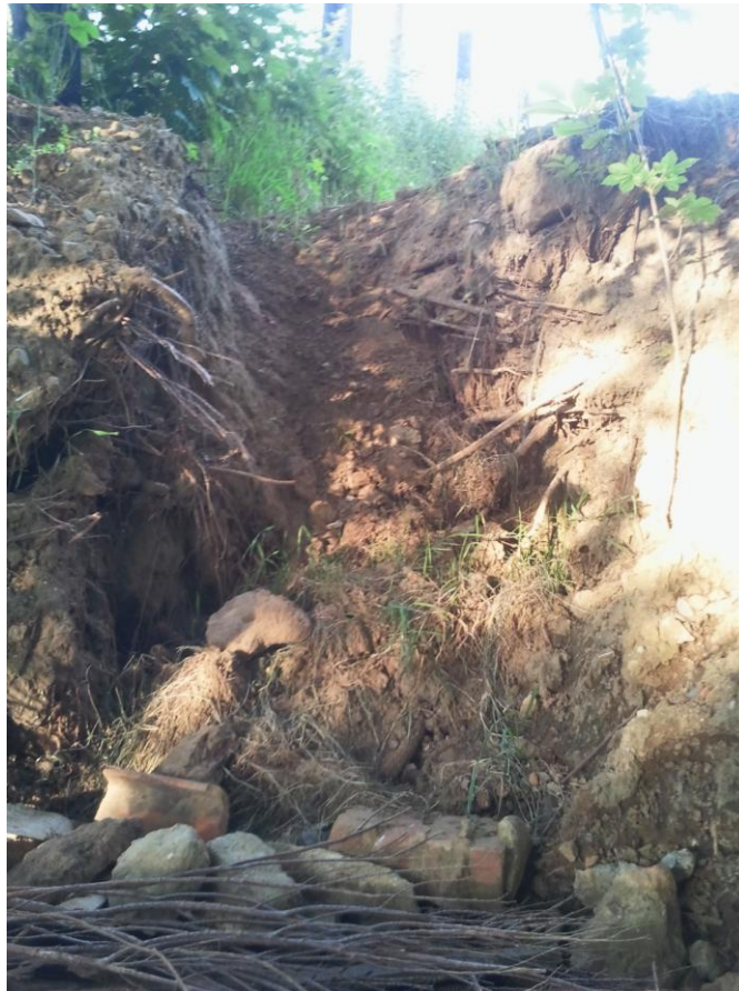
Foto 2 : bermravin in talud van holle weg
