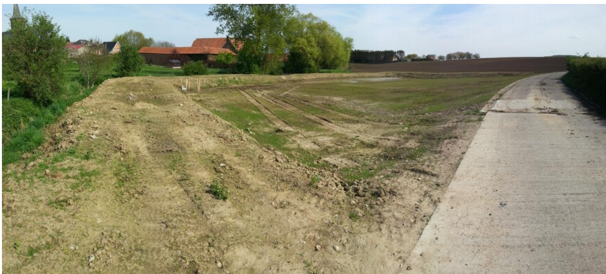
Foto : uitgevoerde maatregelen in de Herckenrodestraat
