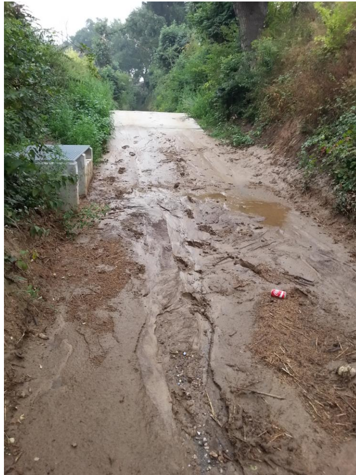
Foto 6 : drempel houdt modderstroom tegen (augustus 2015)
