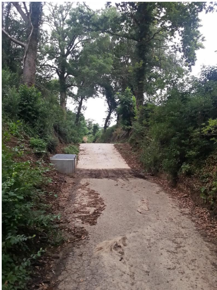
Foto 3 : Diepenstraat na uitvoering werken (zelfde locatie als foto 2)
