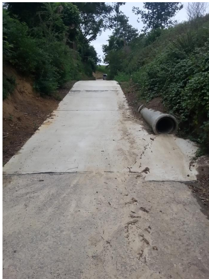
Foto 5 : Diepenstraat na uitvoering werken (zelfde locatie als foto 4)
