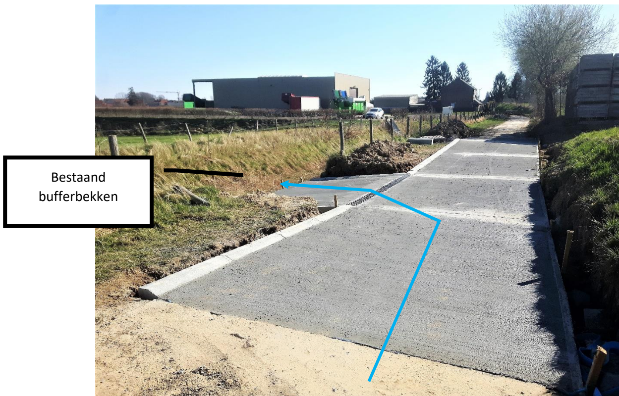
Foto 2 : Een wegaanpassing (wegverlaging én -verhoging) zorgt er voor dat de modderstromen beter worden afgeleid naar het bestaande bufferbekken
