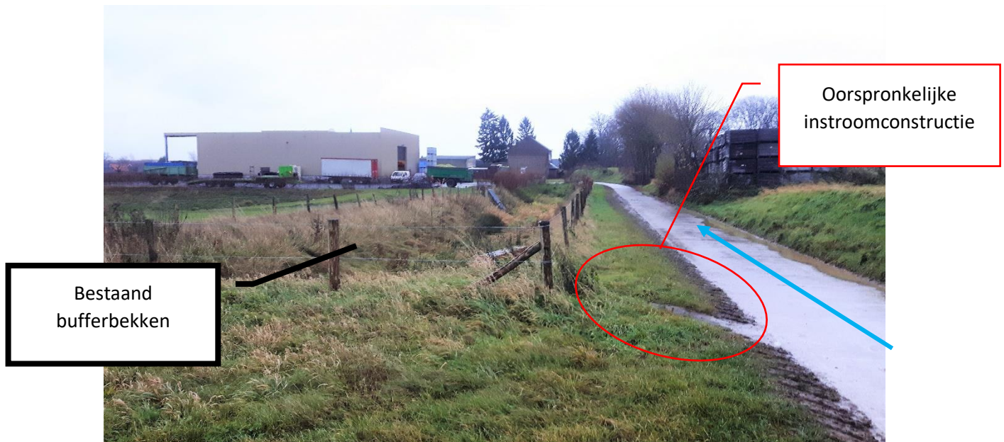
Foto 1: Toestand vóór de aanpassingswerken. Het afleiden van water- en modderstromen van straat naar bufferbekken verloopt niet optimaal.
