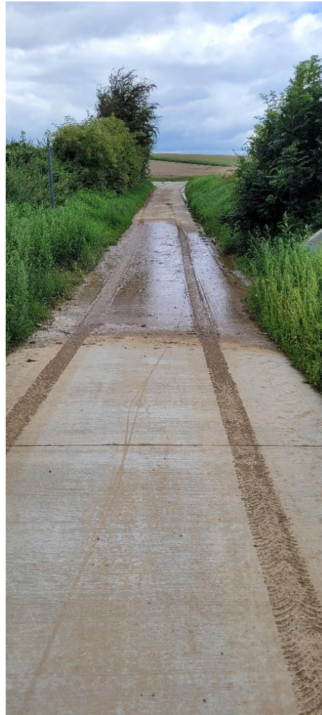
Foto 5 : toestand na aanleg drempel (kijkend in opwaartse richting)
