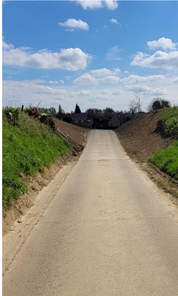
Foto 2 : toestand na aanleg van wegdrempel (kijkend in afwaartse richting)
