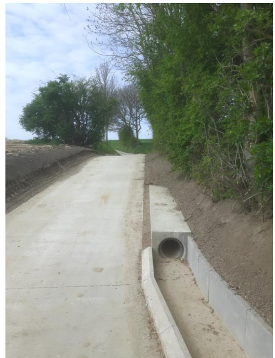
Foto 4 : Bosstraat na de werken (zicht opwaarts)
